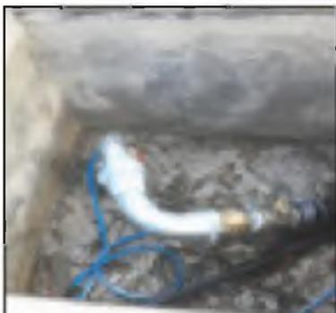
A fin de subsanar los inconvenientes de abastecimiento de agua en cantidad y calidad suficientes se resolvió la realización de una nueva perforación de agua en febrero de 2018, desde el acuífero confinado, con un encamisado de 115 mm, sellado y estampillado que demandó la instalación de una nueva bomba sumergible tipo Rotor Pump o Grundfos o similar de 3 HP
