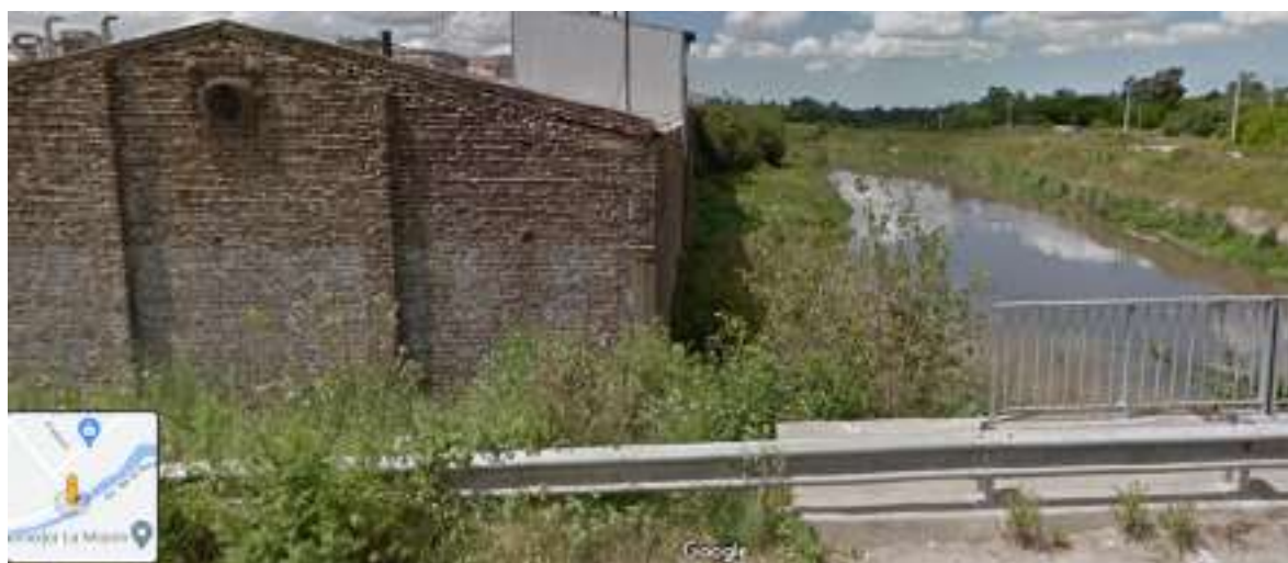
Imagen N°8: Vista lateral del Frigorífico Minguillón y el Río.
